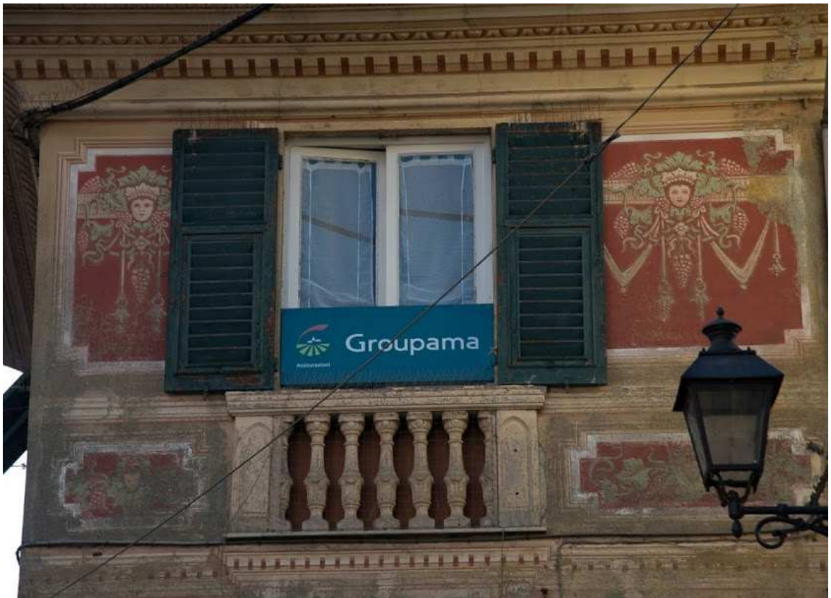
Fonte: Città metropolitana (sopralluogo)
