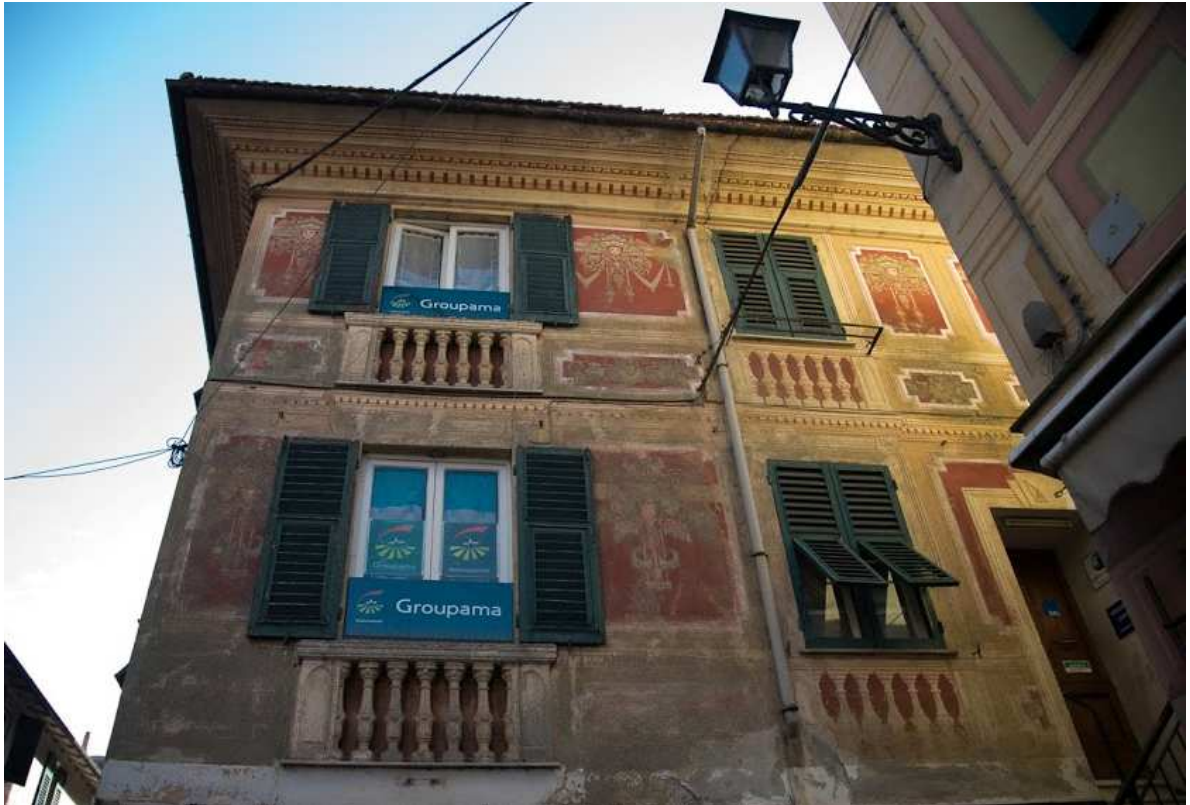
Fonte: Città metropolitana (sopralluogo)
