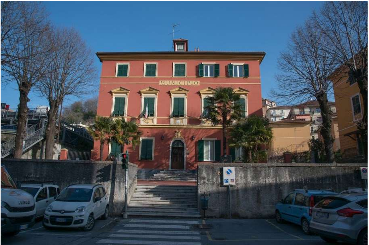
Fonte: Città metropolitana (sopralluogo)
