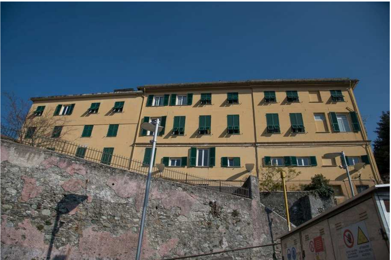
Fonte: Città Metropolitana (sopralluogo)
