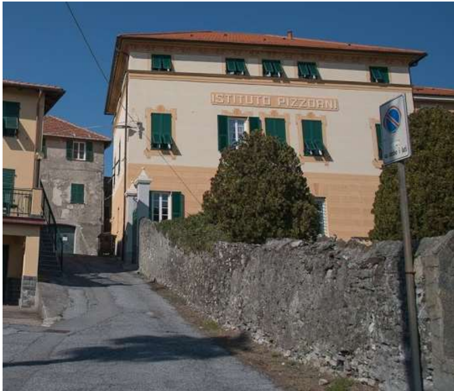
Fonte: Città Metropolitana di Genova (sopralluogo)
