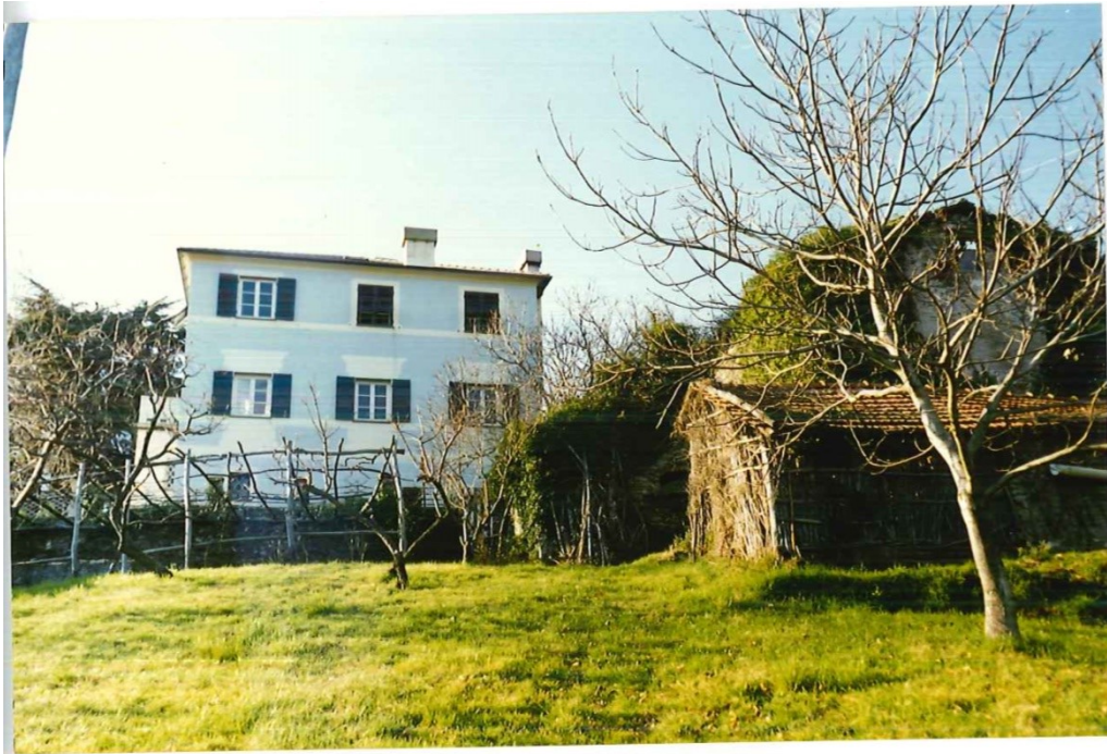
FOTO 246: Mainetto, Villa Campanella, la facciata principale e le costruzioni di servizio.
