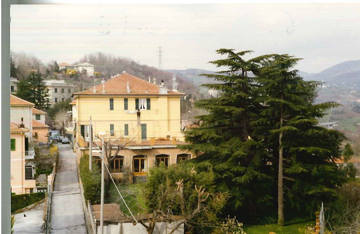
FOTO 202: San Cipriano, Villa Ferrero, il lato sud.
