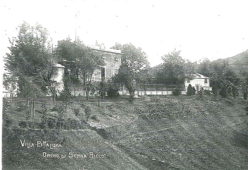
IMM. 47: Costa di Orero, Villa Pittauga con la casa dei manenti sulla destra ed una parte dello spazio naturale in una veduta del Novecento.
