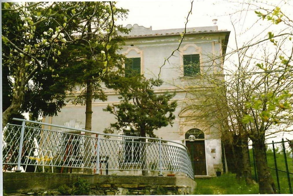
FOTO 238: Valleregia, Casa S. Maria Santissima, veduta dell'edificio e del giardino.
