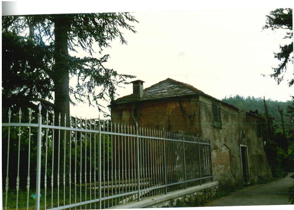
FOTO 255: Costa di Orero, Villa Pittauga, la casa dei manenti.
