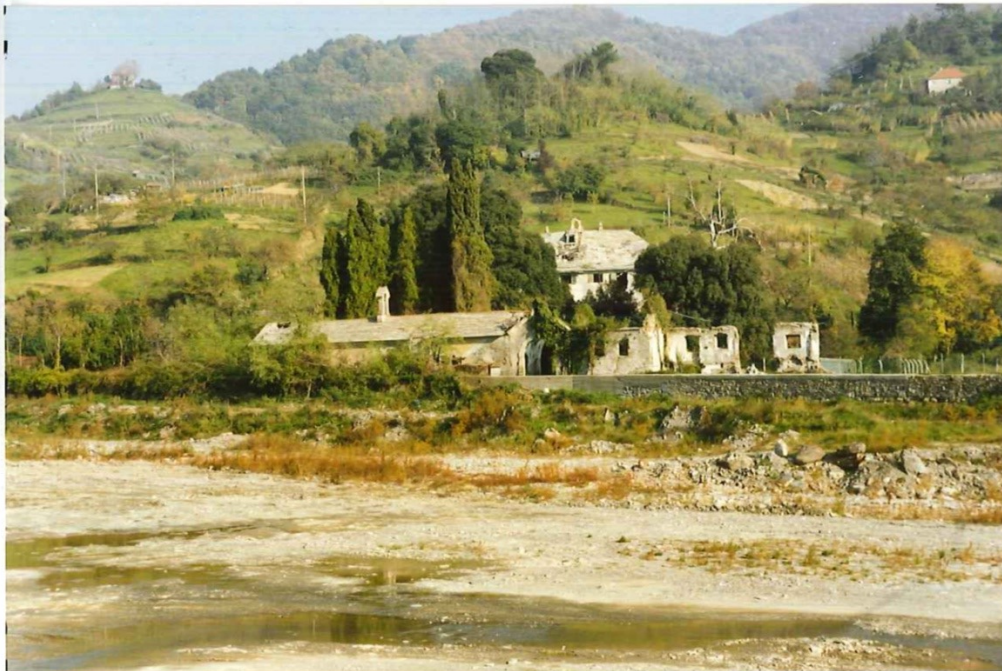
FOTO 219: Castagna, Villa Negrotto - Cambiaso, la villa e la cappella prima della ristrutturazione.
