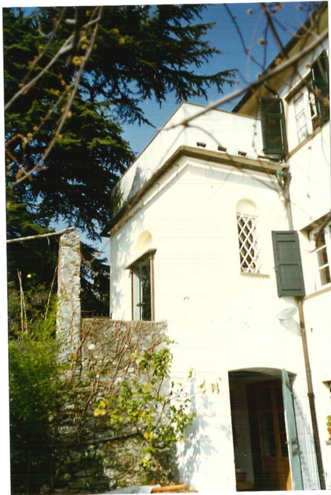
FOTO 247: Mainetto, Villa Campanella, particolare dell'angolo con la cappella al piano superiore.
