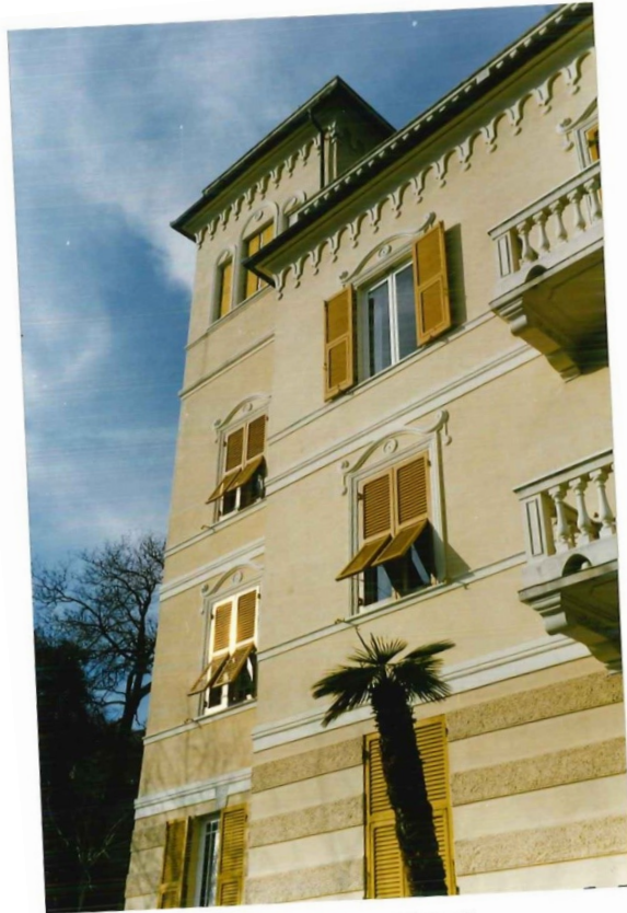
FOTO 288: Pedemonte, La Torretta, particolare della torretta.
