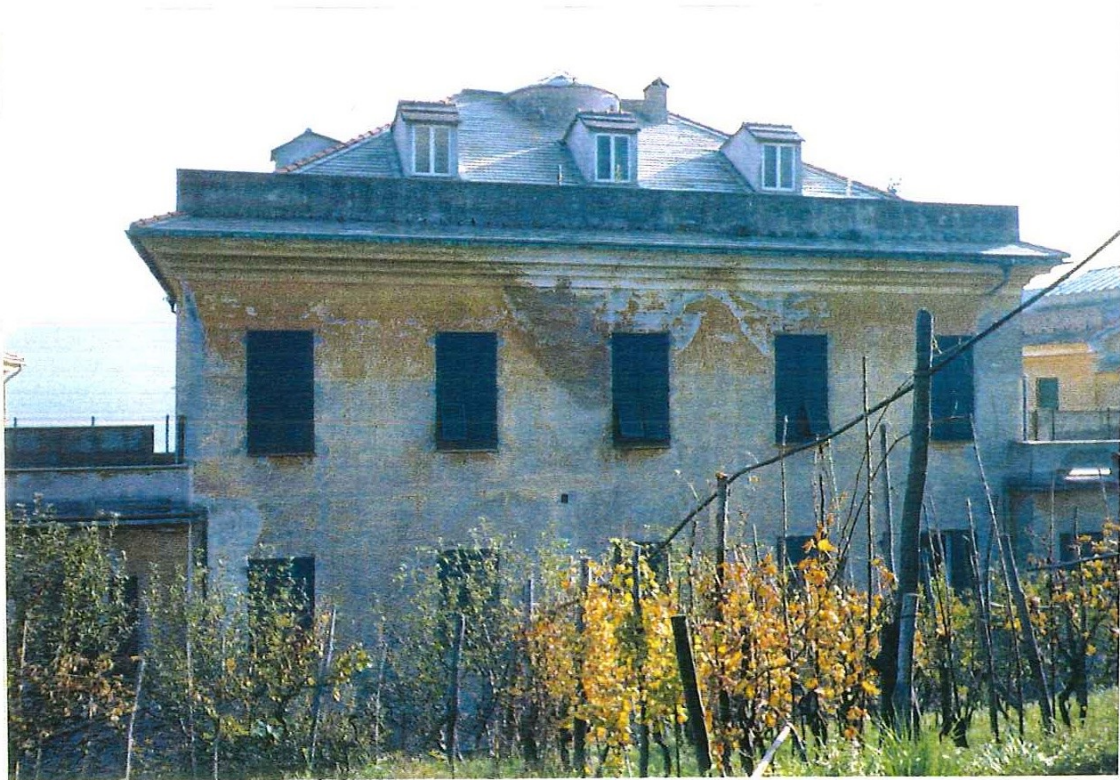
IMM. 53: San Cipriano, il retro di Villa Venzano - Calcagno.
