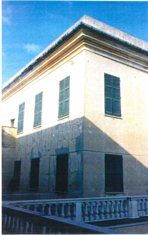
IMM. 54: San Cipriano, Villa Venzano - Calcagno, particolare della balconata.
