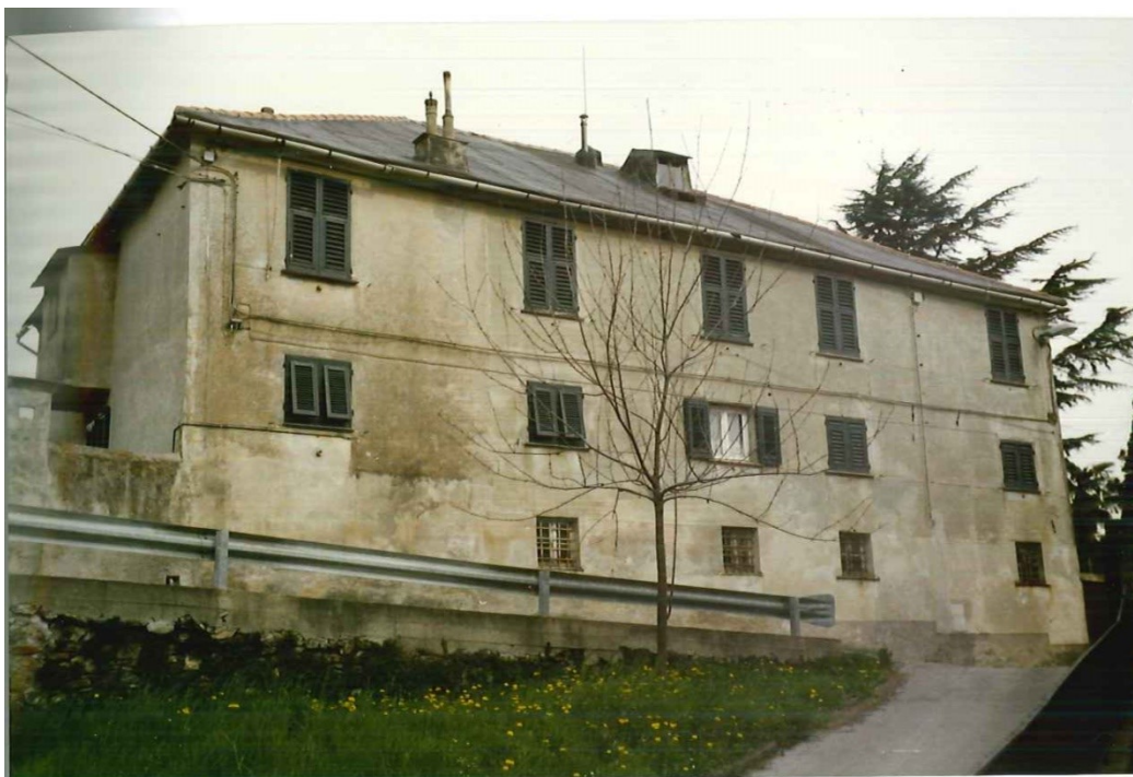
FOTO 204: San Cipriano, Villa Borlasca, la facciata principale.
