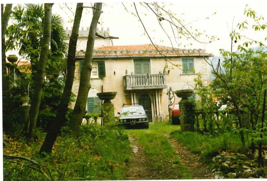
FOTO 267: Magnerri, Villa Ghilino, il viale d'accesso e la facciata principale.
