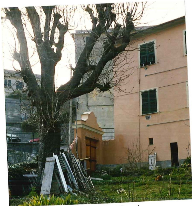
FOTO 261: San Cipriano, Villa Calcagno, il cancello a sud.
