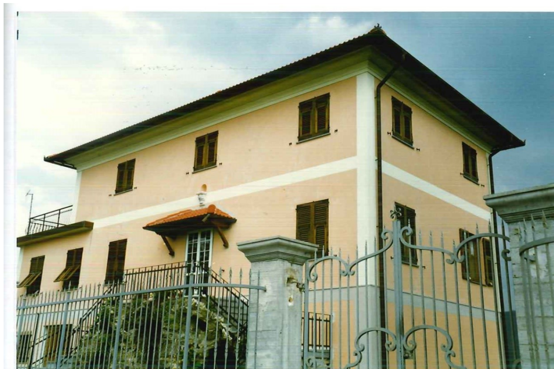
FOTO 254: Costa di Orero, Villa Pittauga, la facciata principale.
