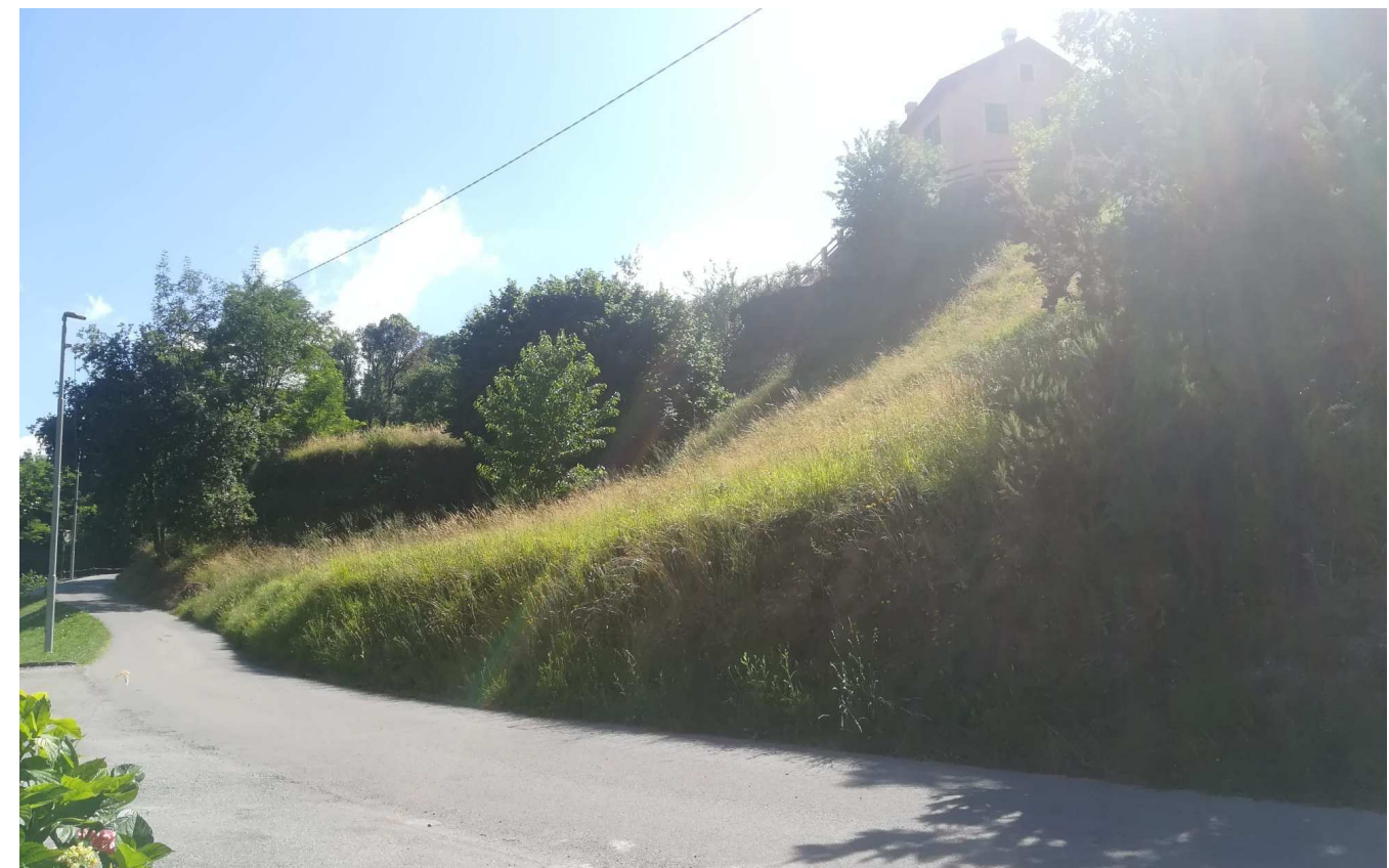
Foto panoramica n. 1
