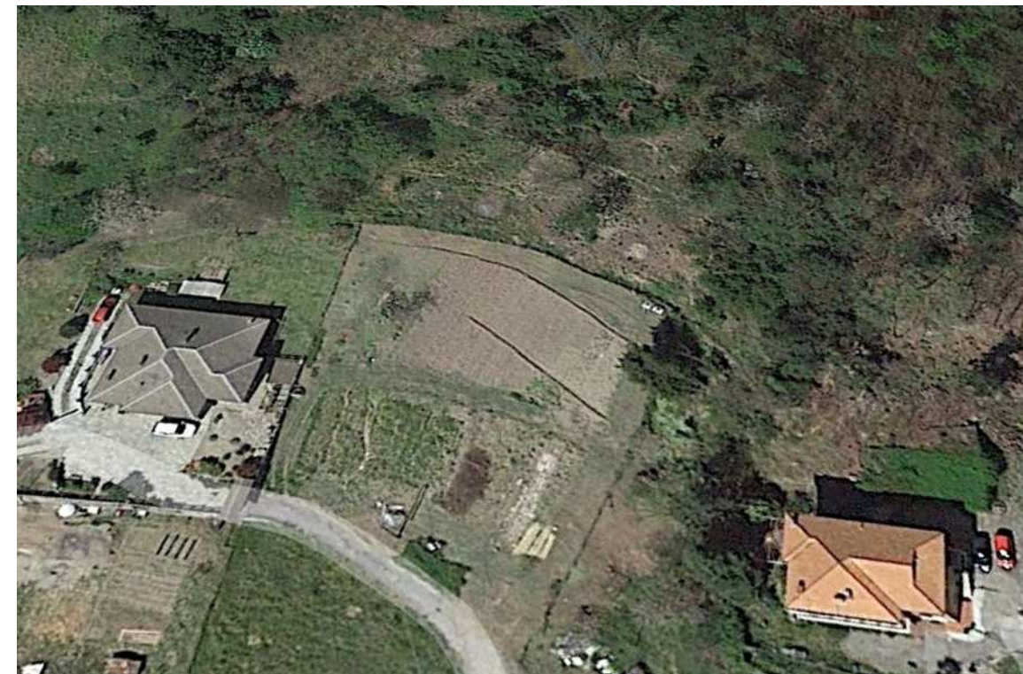
Foto panoramica n. 7
