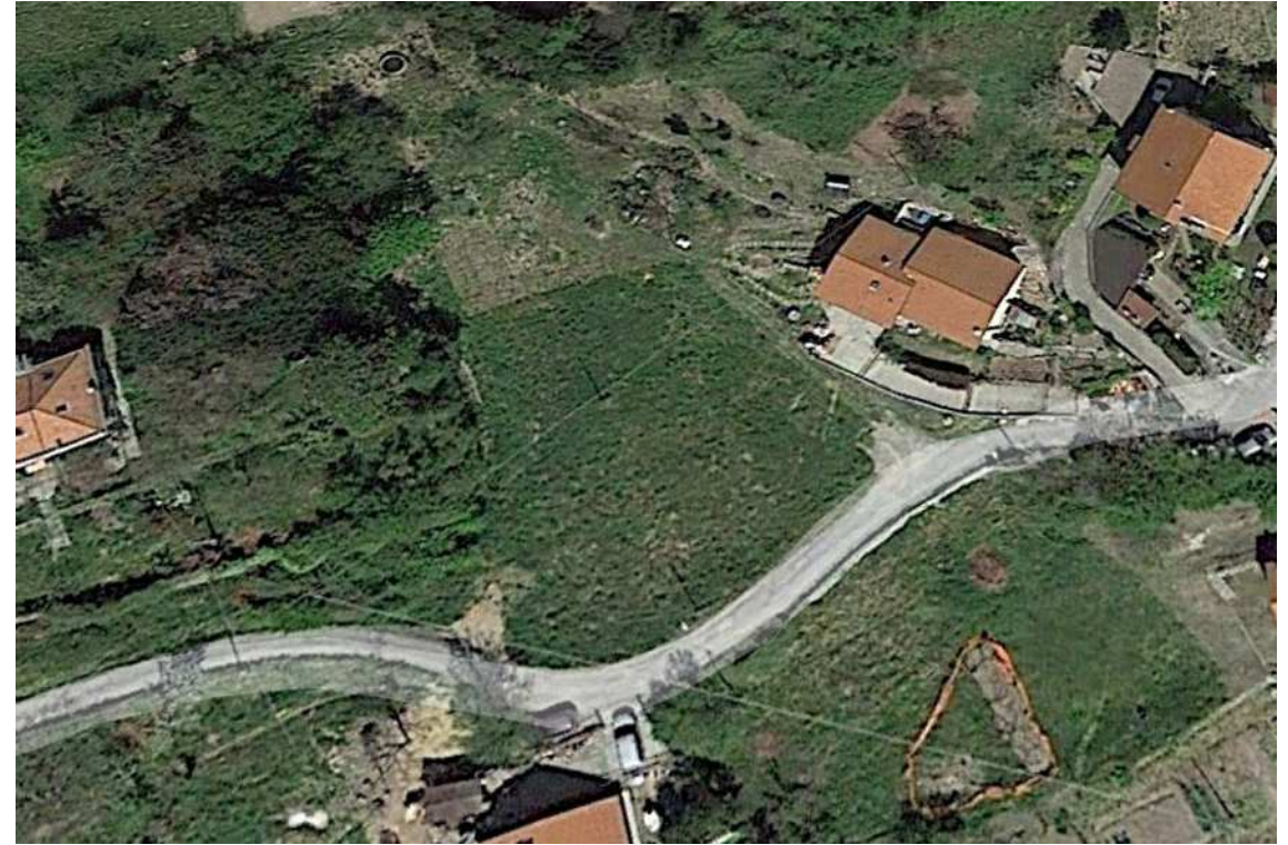
Foto panoramica n. 2
