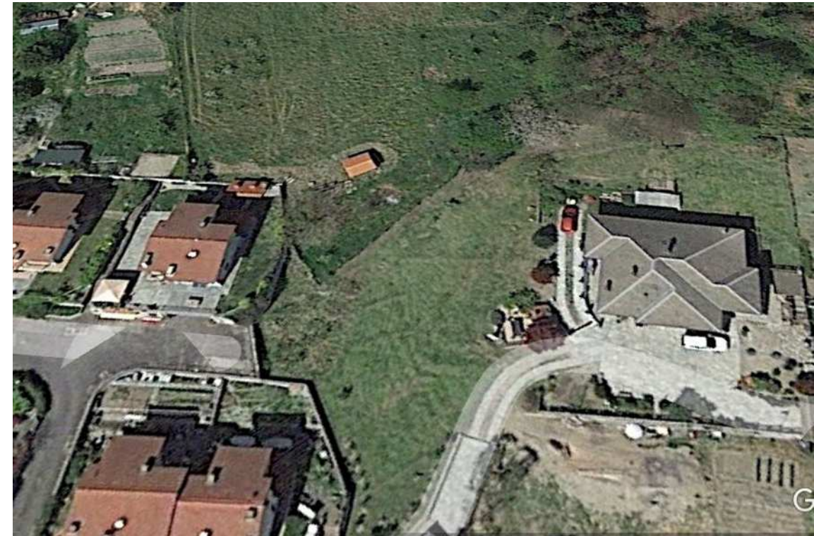
Foto panoramica n. 6
