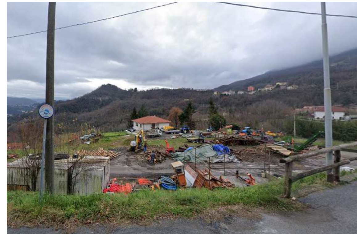
Foto panoramica n. 8
