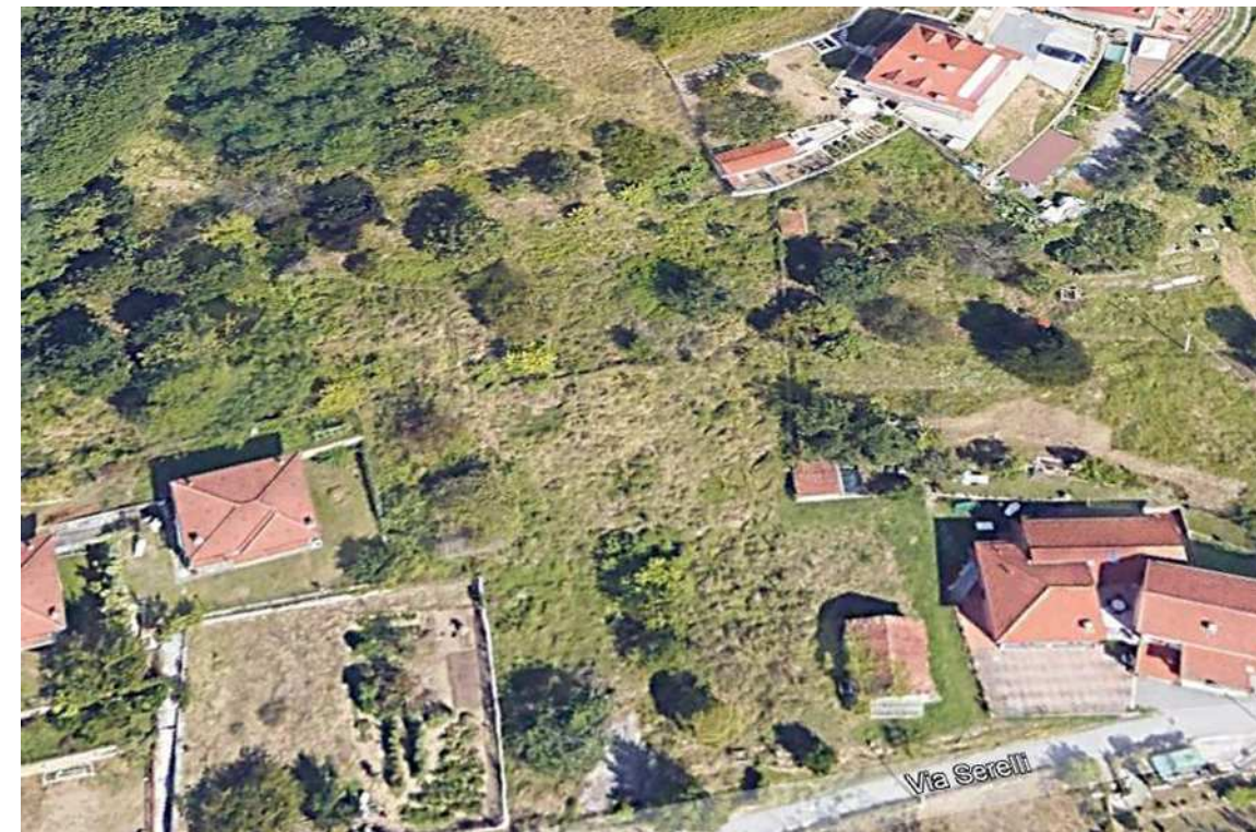
Foto panoramica n. 1
