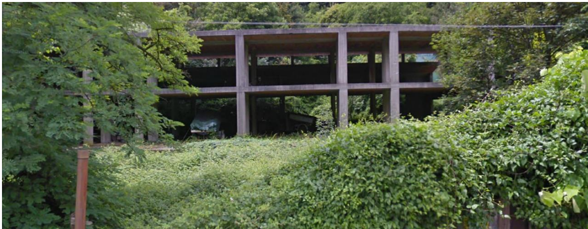
Vista dello scheletro dalla Strada Statale n. 35
