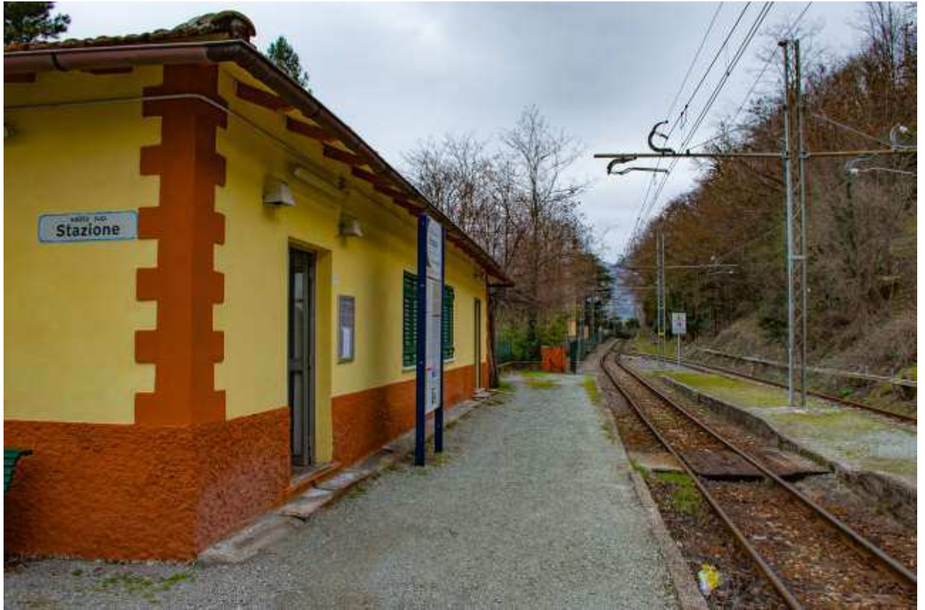
Stazione di Torrazza
