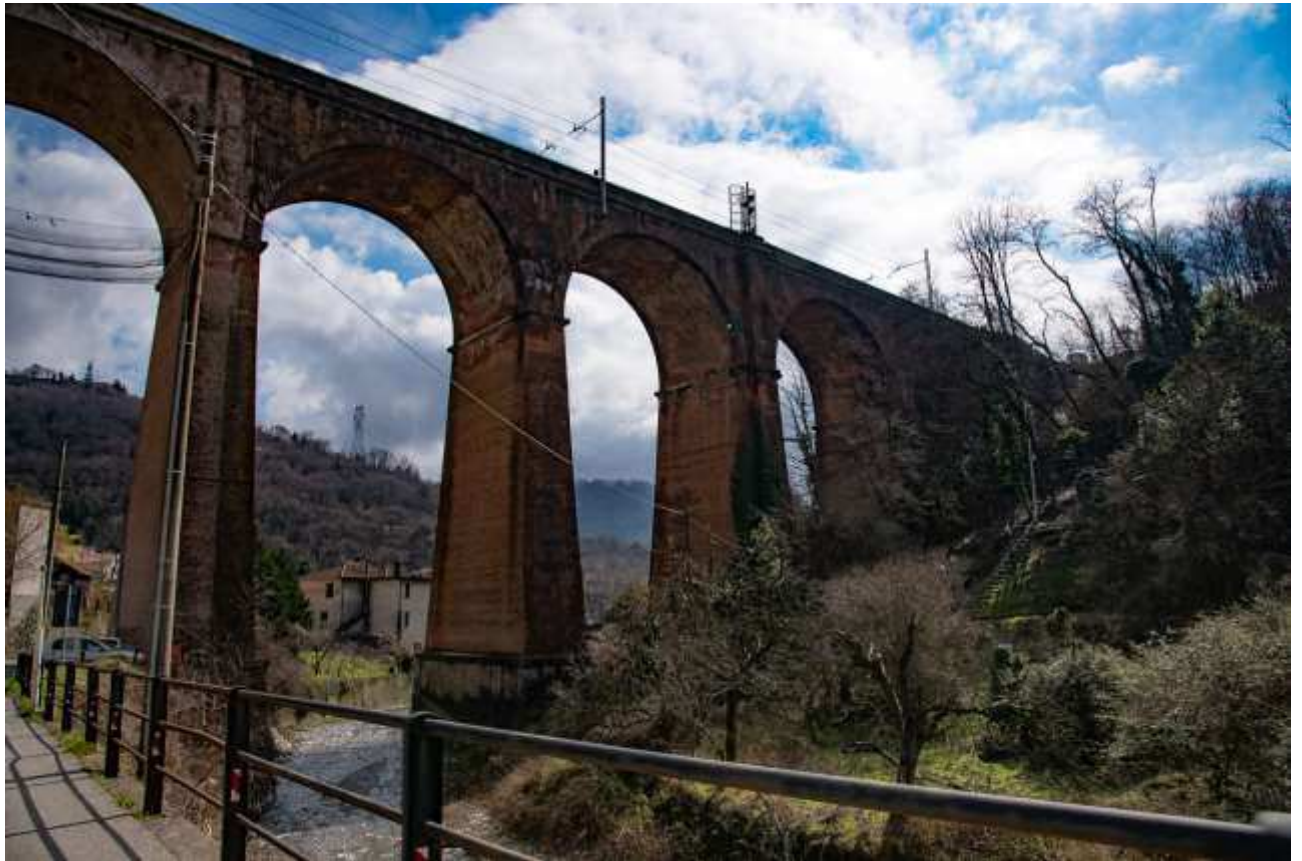
Ponte Dell'Acqua - le pile della ferrovia Genova - Milano
