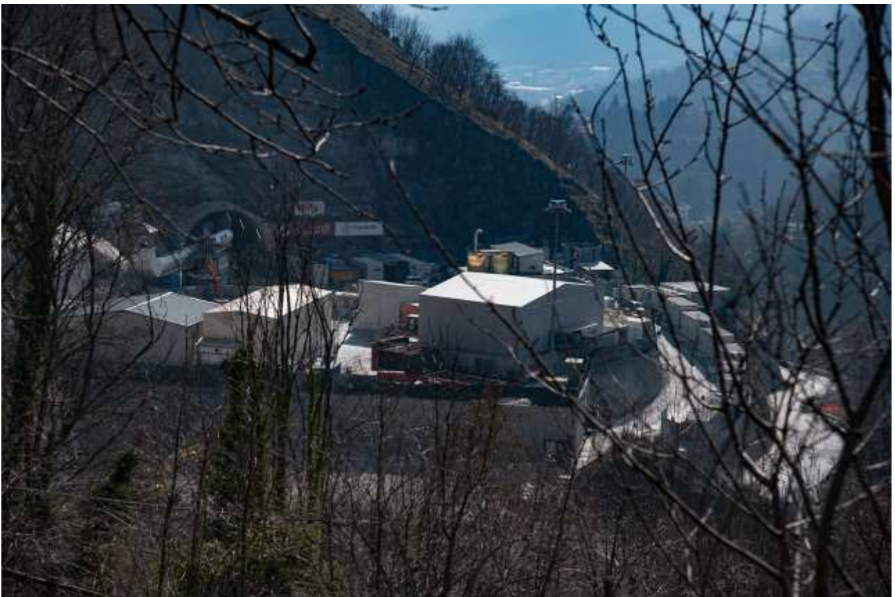
Cava del Monte Carlo - Cantiere TAV "finestra Cravasco"
