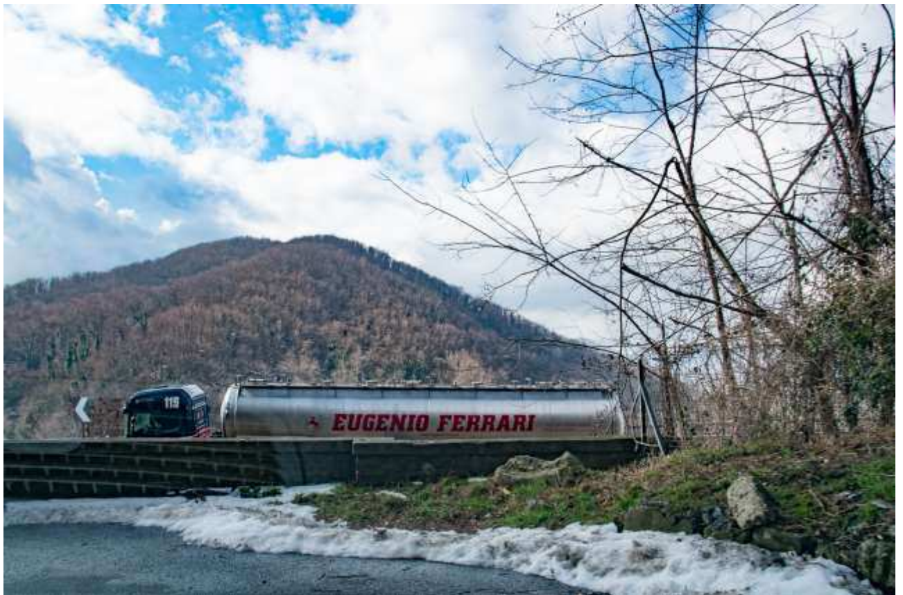
Il transito sul viadotto dell'autostrada dalla SP 84
