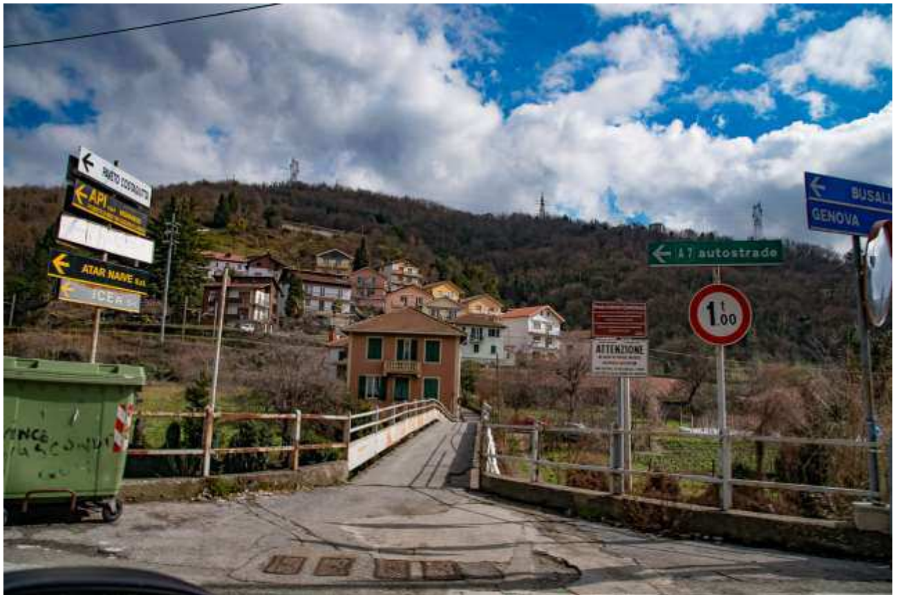
Ponte dell'acqua - ponte sul T. Riccò - vista verso Serra Riccò
