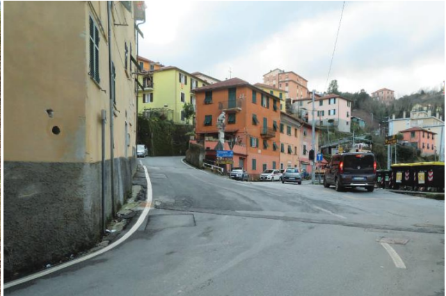
Vista strettoia esistente direzione verso Ceranesi
