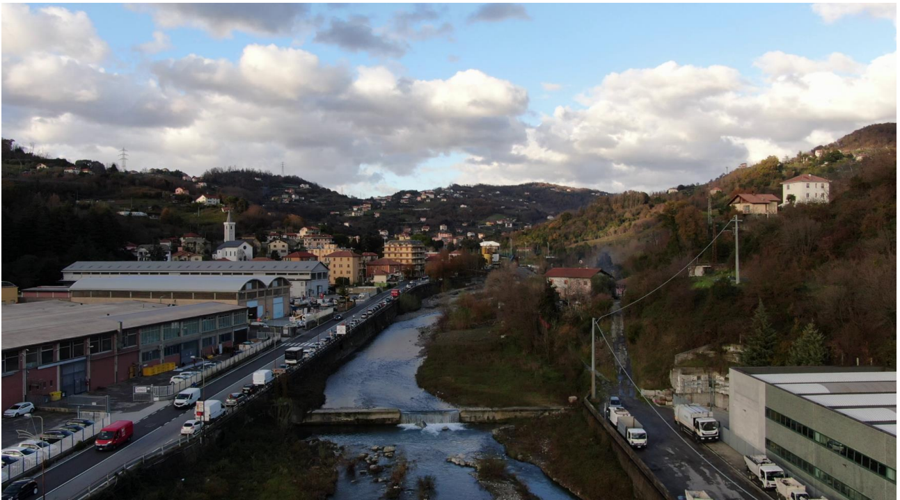
Torrente Secca, vista parte finale di Via Levi a dx e SP 3 a sx
